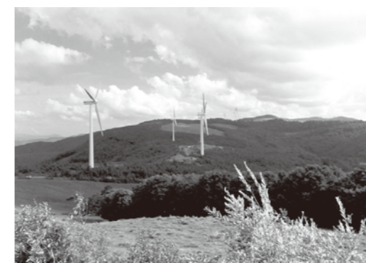
山岳高地に建設された風車
